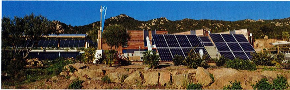
La centrale de Vignola, près d'Ajaccio, une plateforme photovoltaïque comprenant 3.700 m<sup>2</sup> de panneaux solaires, permet de stocker l'énergie produite sous forme d'hydrogène. Un équipement exemplaire, mais encore trop rare sur l'île.
