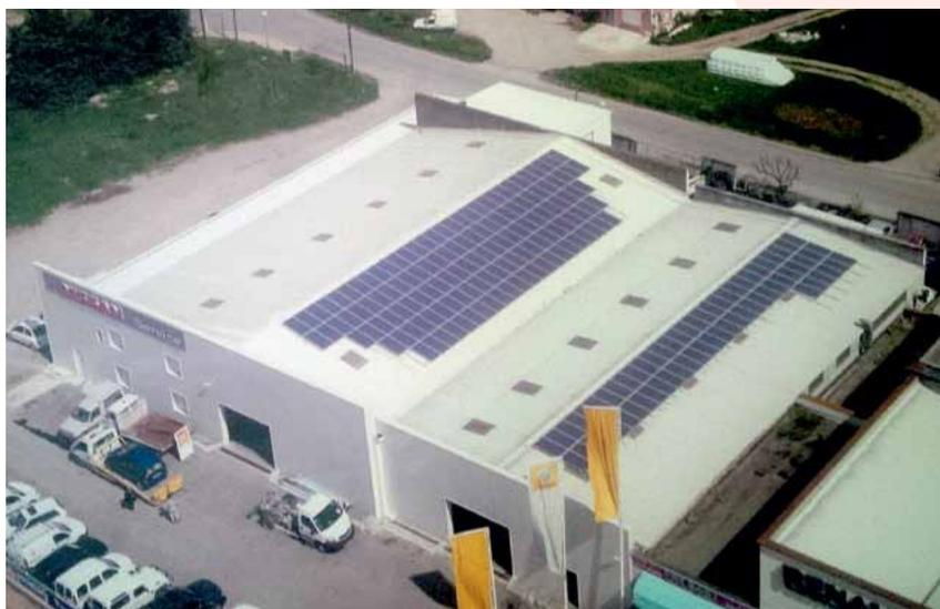
Les panneaux photovoltaïques sont posés à plat sur la toiture du bâtiment et raccordés au réseau. Cette configuration est sans stockage.
