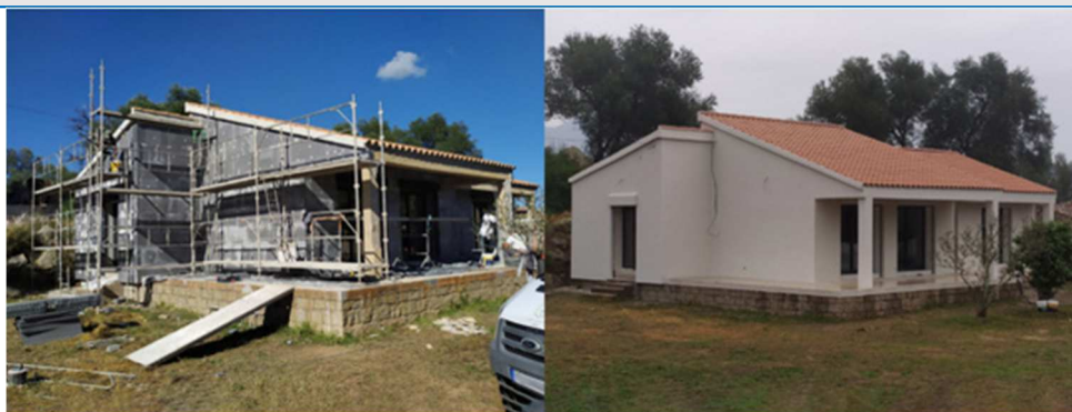
Réalisation de travaux de rénovation énergétique sur une maison individuelle (avant/après).
