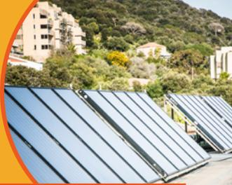
Les panneaux solaires en toiture permettent de chauffer l'eau qui est stockée dans un ballon et peut être utilisée même en l'absence de soleil.
